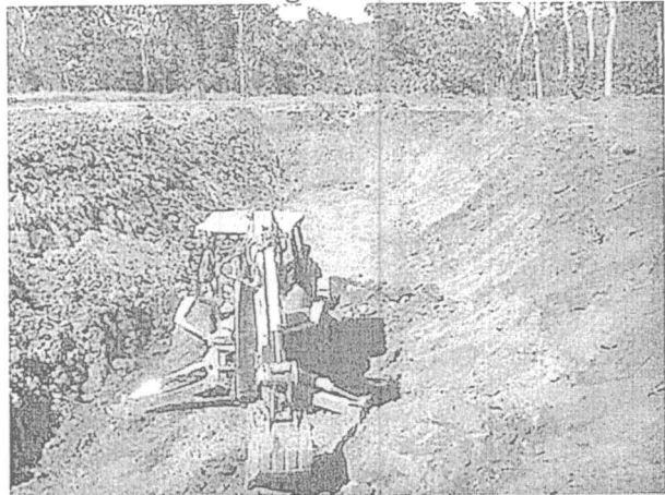
Construcción de laguna y revestimiento de taludes con suelo - cemento
